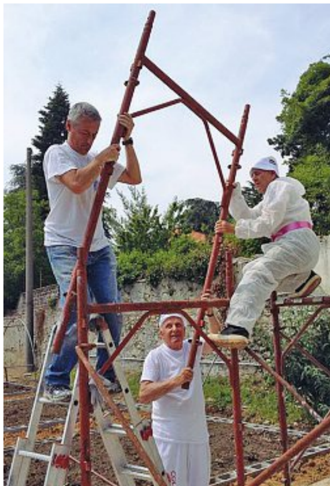
Al lavoro I volontari di «Kaumatua» impegnati in opere di ristrutturazione e integrazioni a Villa Ratti, sede della comunità riabilitativa «Il Volo»
